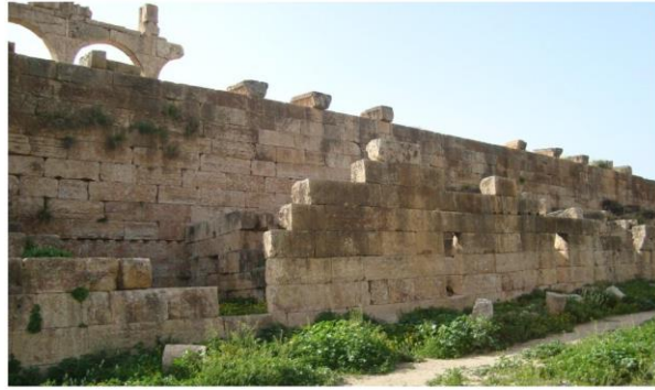
الصورة (٠٢) تواجد الحجر ( تشييد الحوائط ) البازيليكا المسيحية
